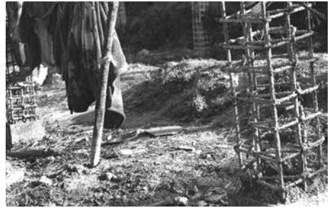
Die Stahlkörbe für die Armierung nach unseren Plänen
